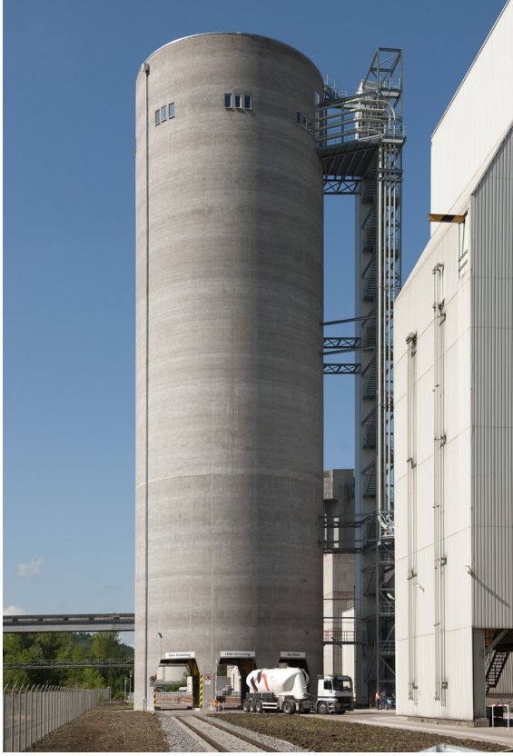
الشكل 1: صومعة IBAU ذات المخروط المركزي
