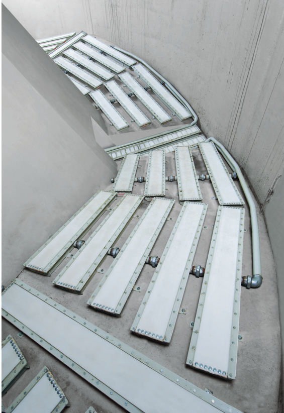
الشكل 2: قاع الصومعة ذات المخروط المركزي
