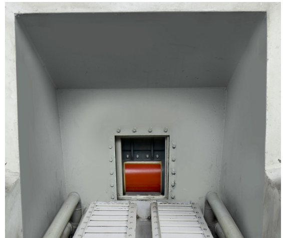
الشكل رقم 3 : منفذ التفريغ مع بوابة التحكم في التدفق
