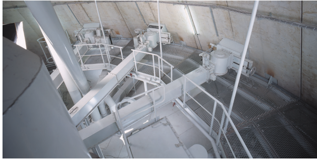
الشكل رقم 4 : عمليات التفريغ في صومعة IBAU ذات المخروط المركزي
